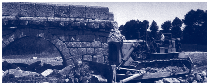
Escavadora no processo de dessecação
